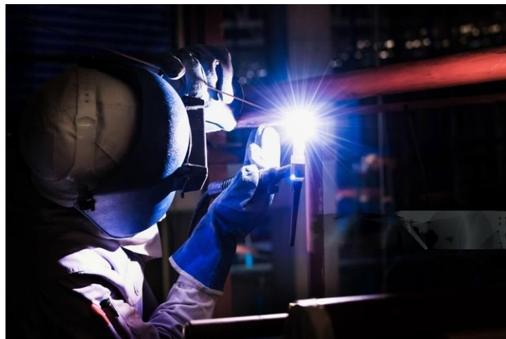
Figur3 3 - Stråling under TIG svejsning.
